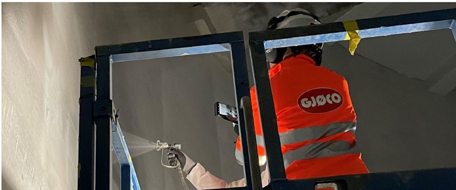
Sparkelen med nanocellulose som forsterkning kan sprøytes direkte på veggen i de nye fisketankene til Salmon Evolution. Elisabet Michelson, direktør fra Gjøco Herdeplast, inspiserer Terje Kleven under påføring av epoxy sprøytesparkel. Foto: Norske Skog Saugbrugs.
